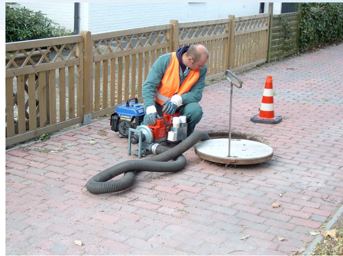
Foto: Nebelung einer Grundstücksentwässerungsanlage
