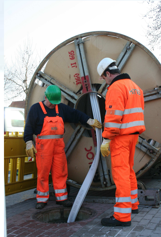
Foto: geschlossene Sanierung
