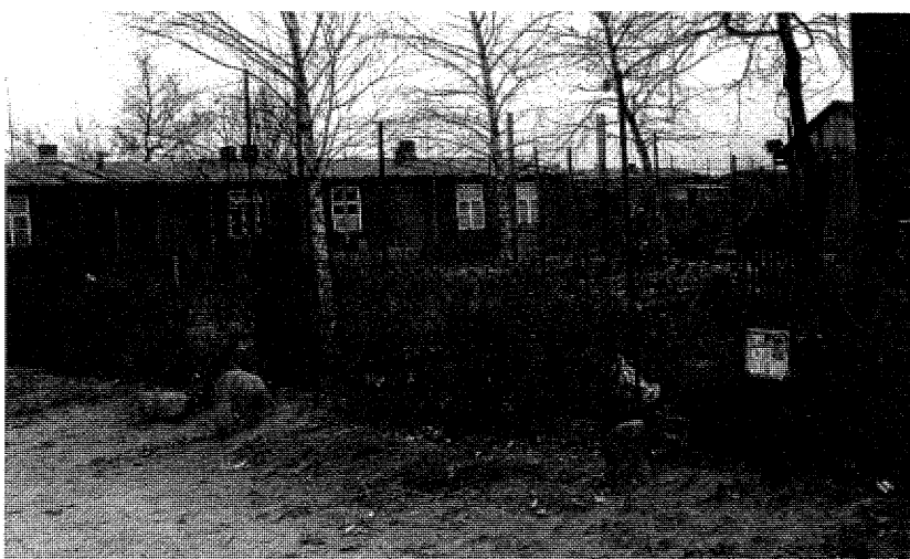
Die Baracken auf dem Gelände Beksberg 1956. Die ersten Vorbereitungen zur Bebauung des Geländes mit Gewerbebetrieben und Wohnhäusern laufen an.
