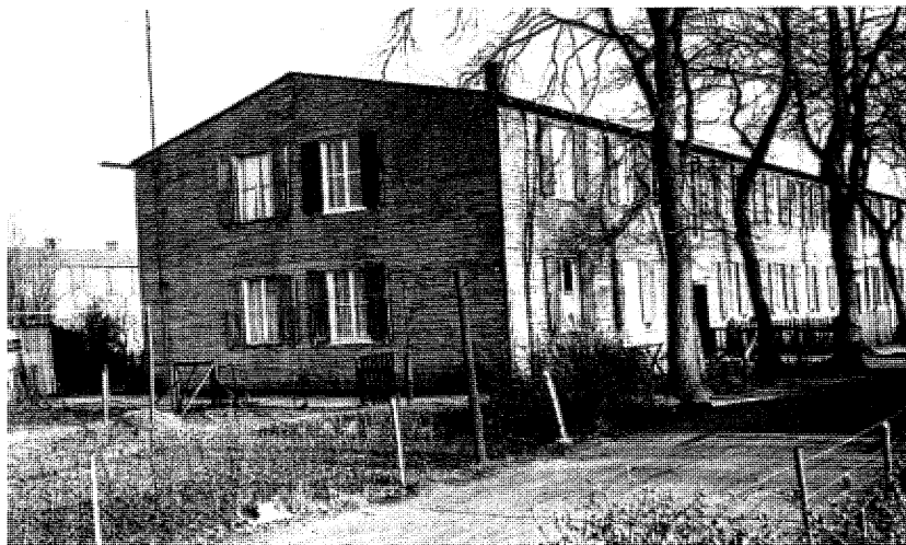
Die 1943 an der Feldstraße errichteten zweigeschossigen Neufert-Baracken. Dieser Barackentyp war solider erbaut als andere; der selbe Typ stand auch am Steinberg. Fotos: Stadt Wedel, 1959
