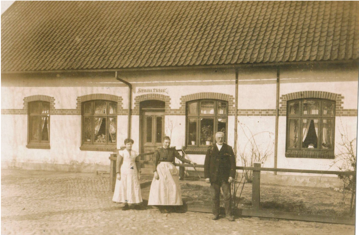
Das Haus in der ABC-Straße 15 in Wedel wurde 1903 gebaut, nachdem das zuvor nebenan bewohnte Strohdachhaus am 26.3.1903 abgebrannt war. Das Haus wurde 2009 abgebrochen. Von links nach rechts: Schwiegertochter Emma Karp (Theodors Frau), Catharina und Hermann Lüchau.
