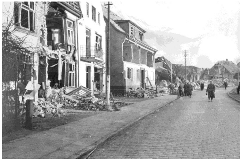
Blick in Richtung Doppeleiche im oberen Teil der Bahnhofstraße
