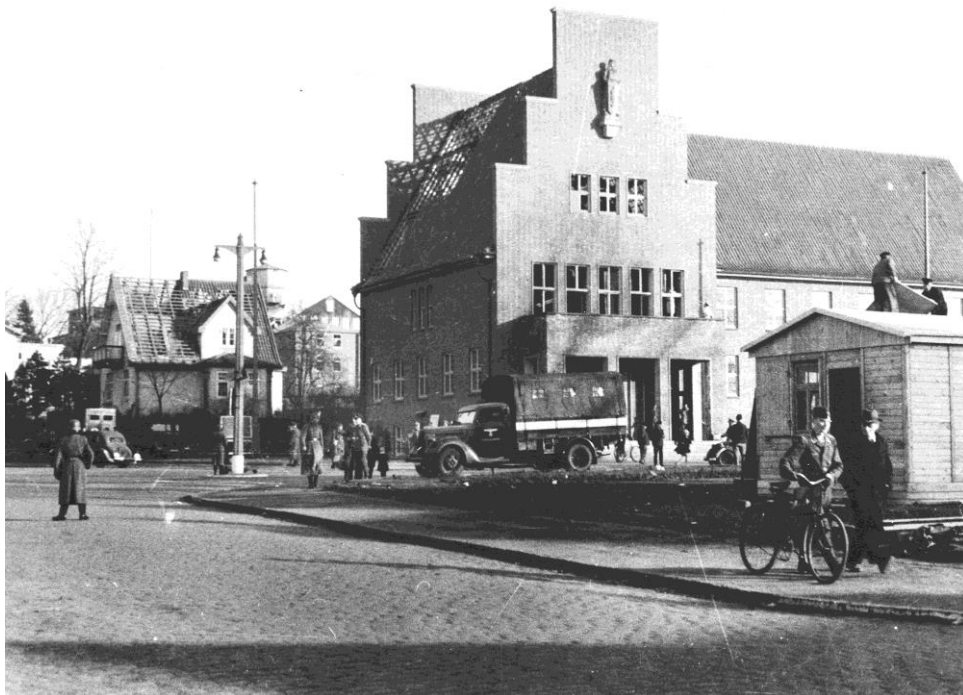
auch am Wedeler Rathaus gab es Gebäudeschäden
