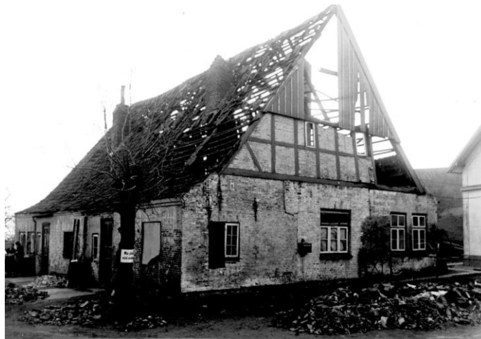
das schwer beschädigte Haus der Familie Treuel in der Schauenburgerstraße (heute Ecke Lüttdal) Auf dem Anschlag am Baum steht: „Wer plündert, wird erschossen!“
