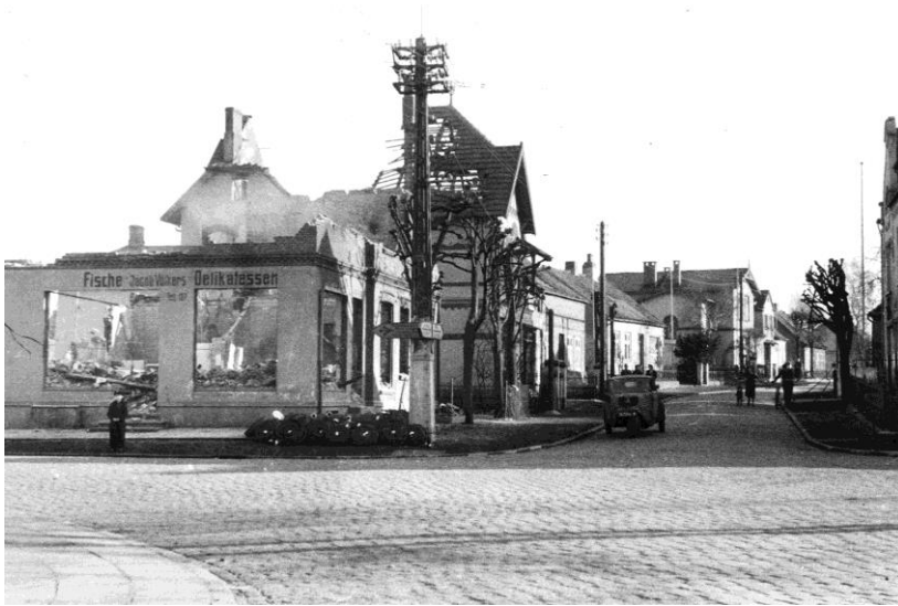
Blick in Richtung Rollberg, links das ausgebrannte Wohn- und Geschäftshaus des Fischhändlers Völkers
