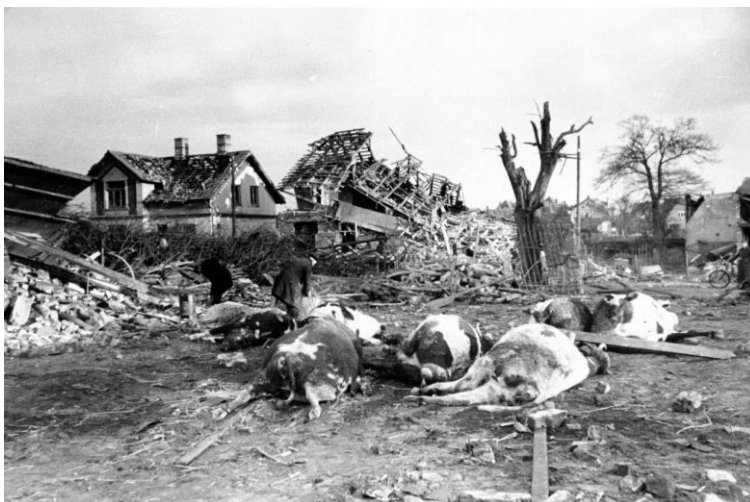
Der durch eine Luftmine total zerstörte Bauernhof von Dittmer Biesterfeldt in der Bahnhofstraße 47.
