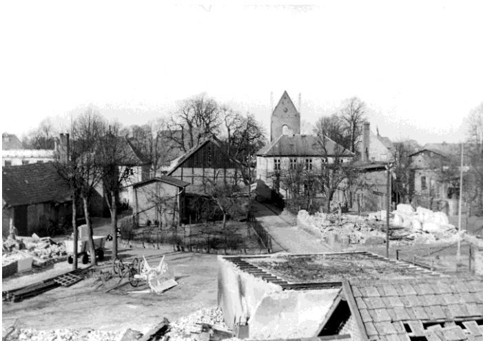
Blick von der Schulstraße in Richtung Kirche im Vordergrund Reste vom zerstörten Bauernhof „Freihof“, im Hintergrund die Gaststätte „Freihof“
