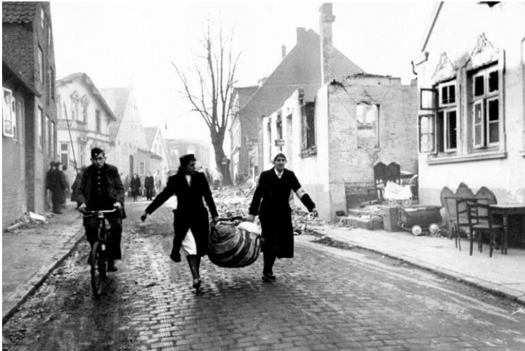
Blick in die Mühlenstraße in Richtung Marktplatz, rechts die zerstörten Häuser von Greve und Thode. Reste des ersten zerstörten Hauses, befanden sich viele Jahrzehnte hinter einer Holzwand, diese wurde erst vor kurzer Zeit beseitigt und durch einen Neubau ersetzt.
