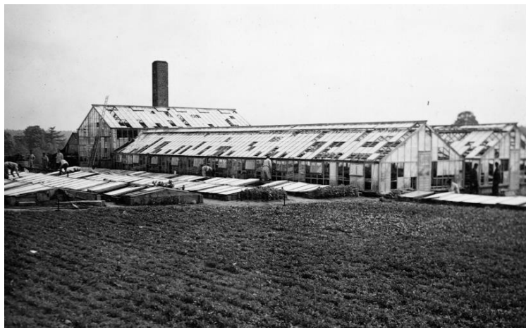
die beschädigten Gewächshäuser der Gärtnerei Schormann
