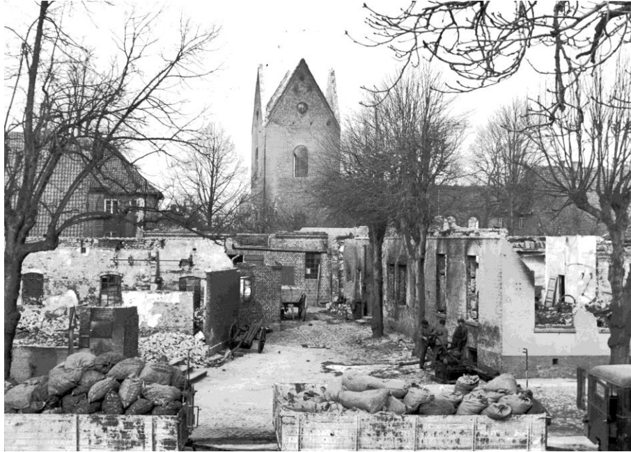
hinten links das nur wenig beschädigte Pastorat
