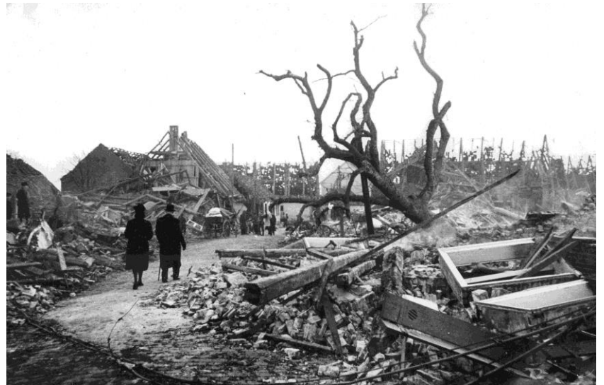
im Hintergrund der zerstörte Bauernhof von Albert Breckwoldt vorne die Reste vom Alten- und Pflegeheim
