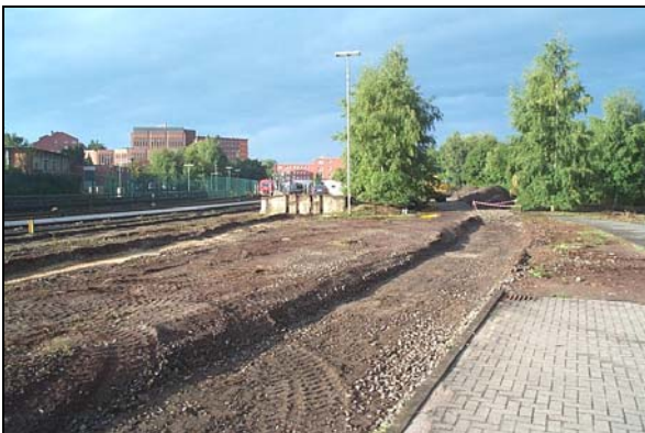
Foto 3: Blick vom Stellwerk auf die Laderampe
