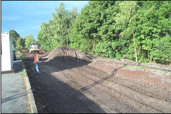
Foto 1: Ausbau des Gleisschotterbettes, rechts Gehölzbestand
