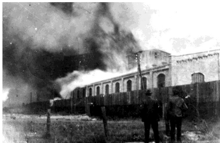
Blick auf das brennende Fabrikationshauptgebäude
