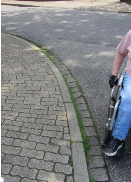
Foto Nr.2 Kantsteinabsenkung Hoophof/Mühlenweg
